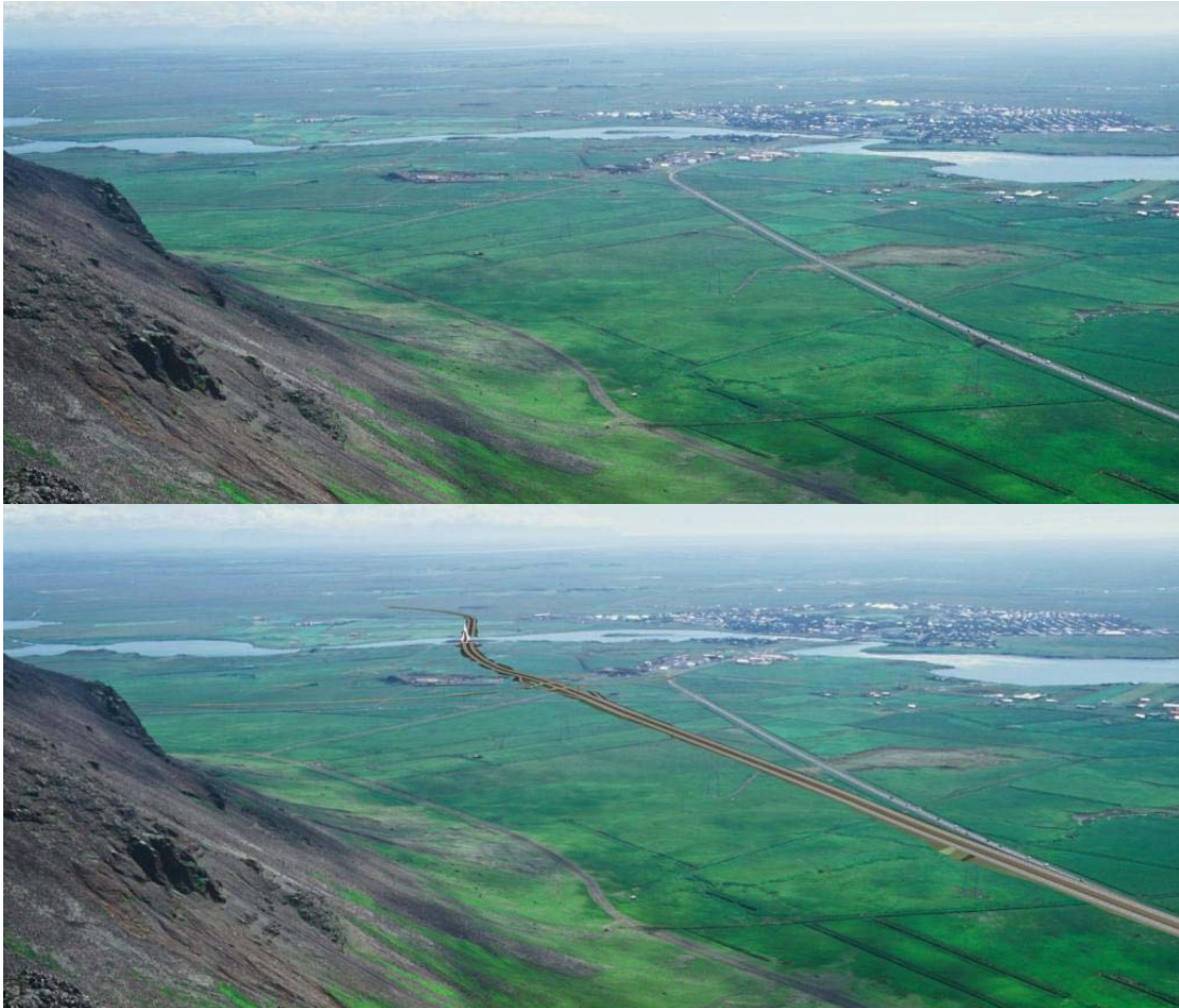
Mynd 4-26 Suðurlandsvegur verður lagður norður fyrir Selfoss og ný brú byggð yfir Ölfusá. Valkostur 1 er sýndur á myndinni (aðrir valkostir eru í viðauka 1).
